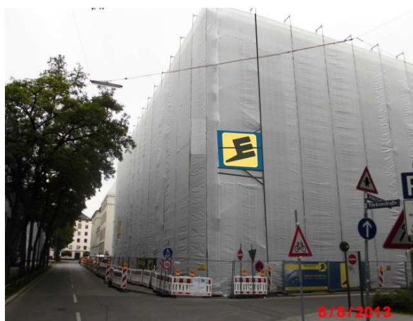
Komplette Einhausung des Gebäudes (Staub-, Lärm- und Sichtschutz)
